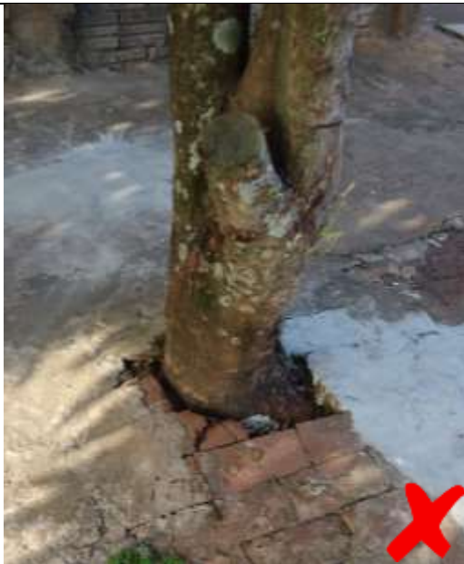
Figura 30: vista da calçada irregular
