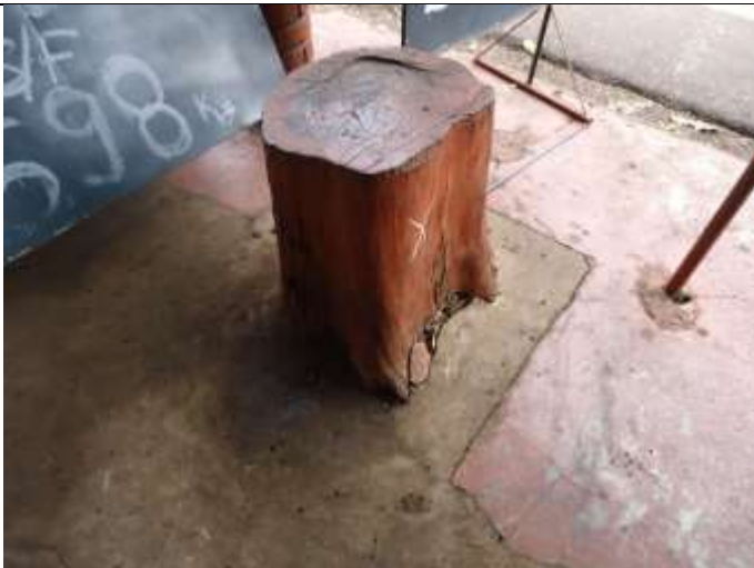
Figura 21: Ausência de prática de remoção dos troncos.
