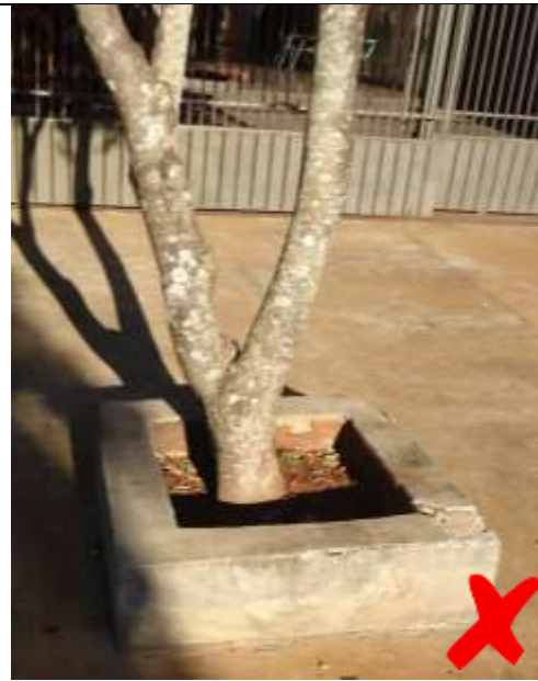
Figura 31: vista da mureta irregular
